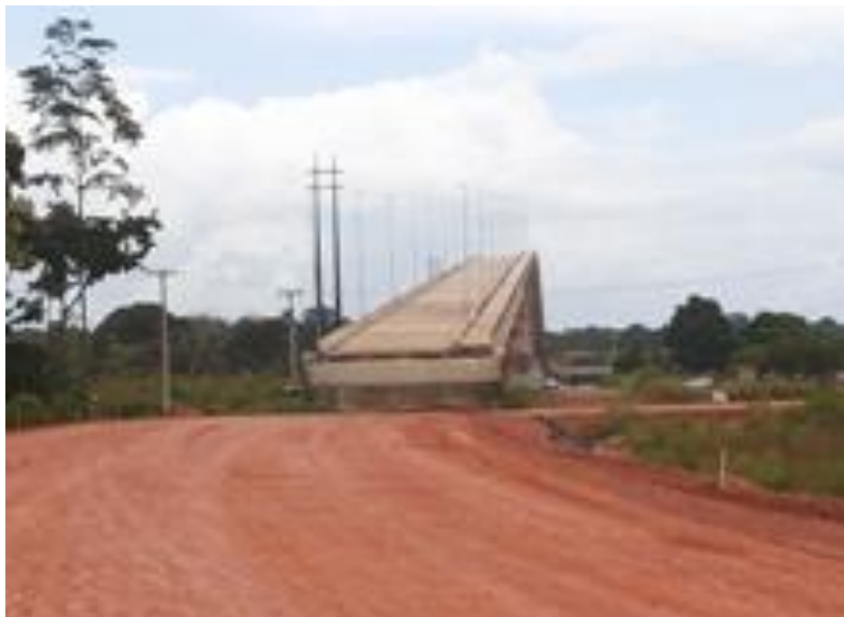
Figura 15: Cabeceira da ponte sobre o rio Matapi.
