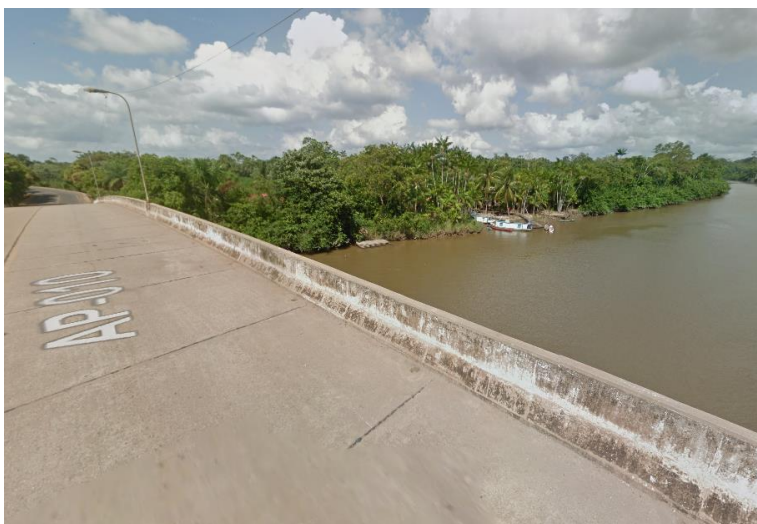
Figura 18: Ponte sobre o rio Vila Nova.
